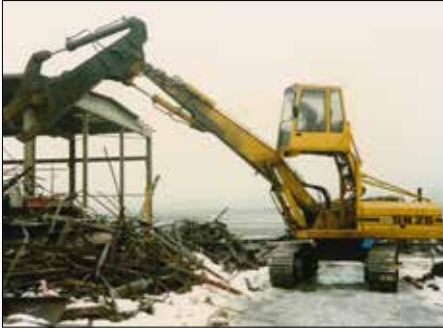
1980: SR26, selektiver Rückbau
